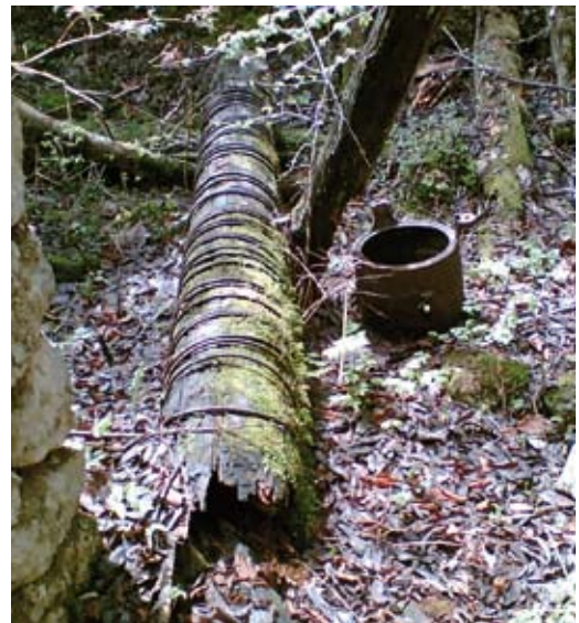
Un pezzo di condotta
